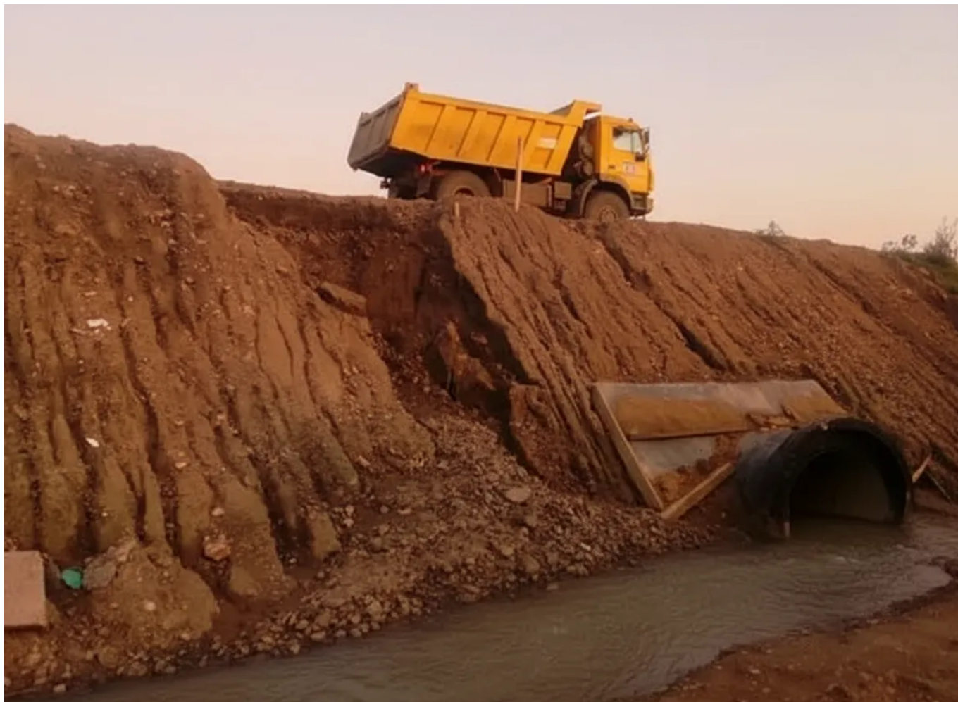
Рисунок 4. Сползание откоса после оттаивания мерзлого грунта, отсыпанного зимой
