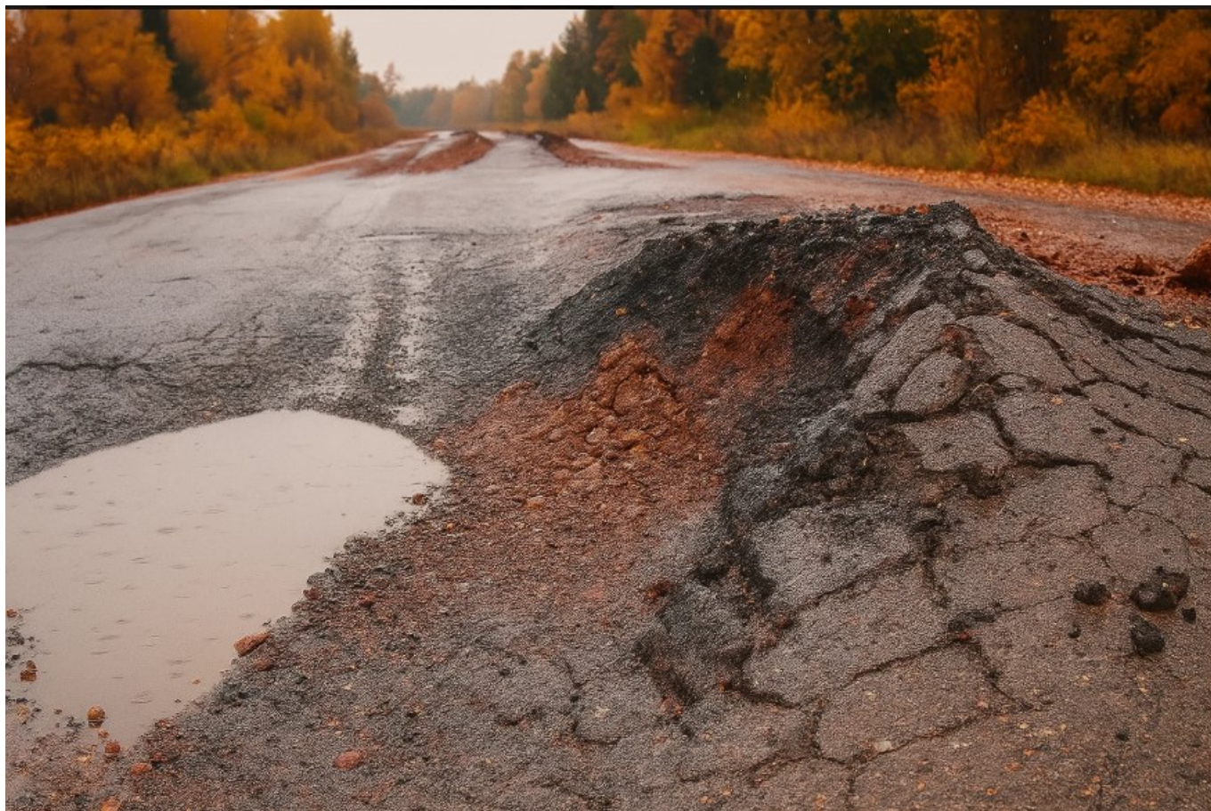
Рисунок 3. Бугры пучения на дорогах Красноярского края
