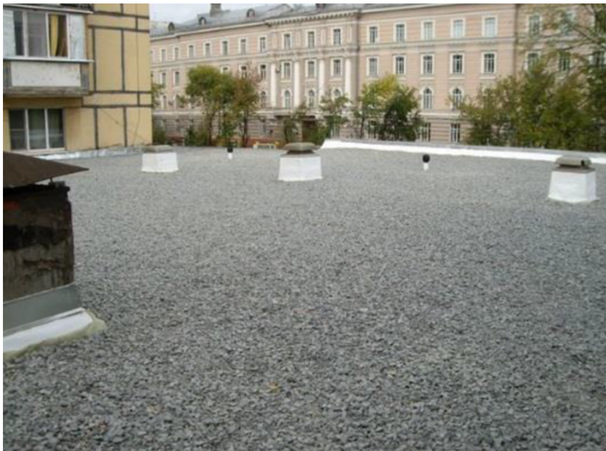
Пример выполнение балластного слоя:
