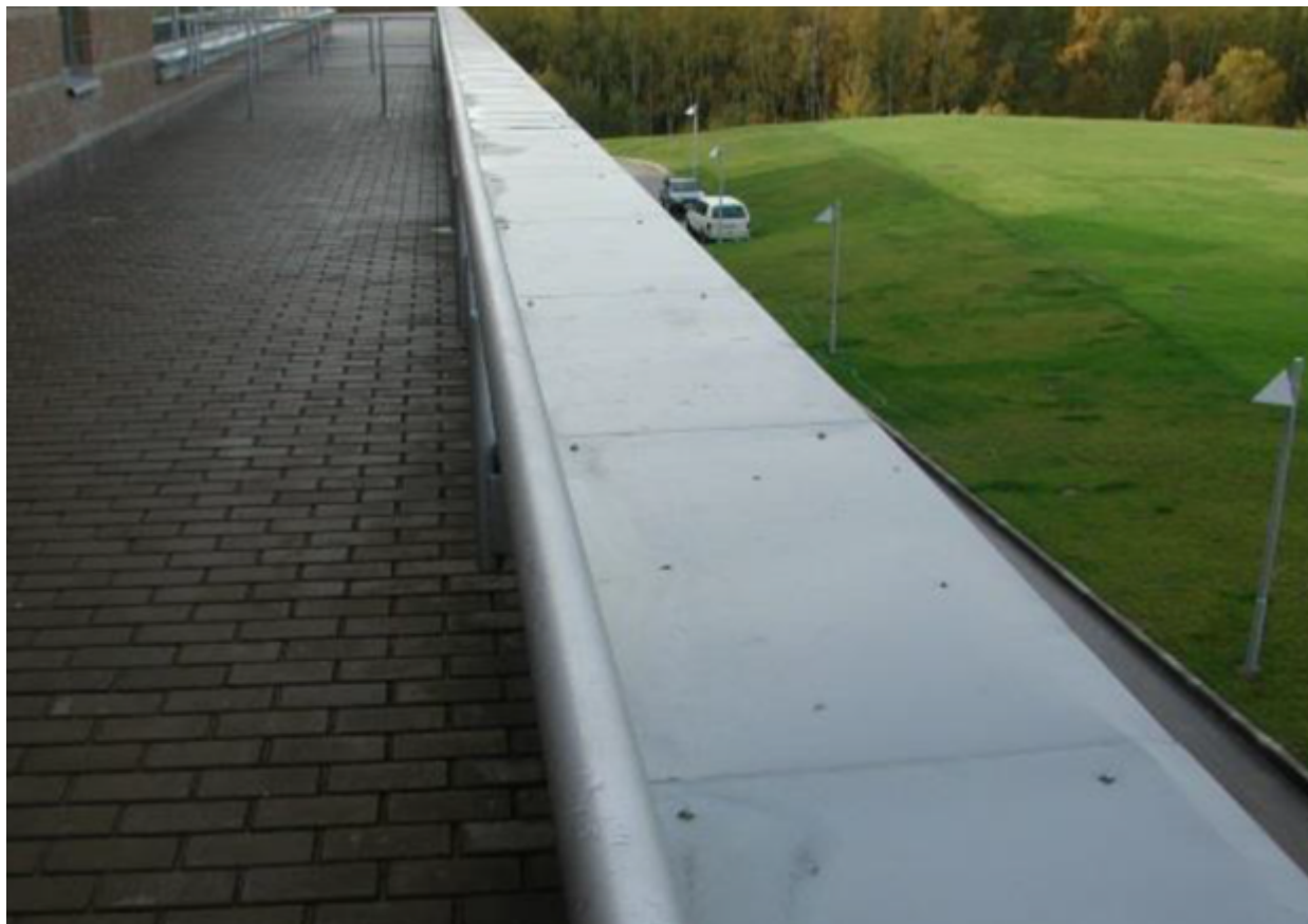
Пример выполнение балластного слоя:
