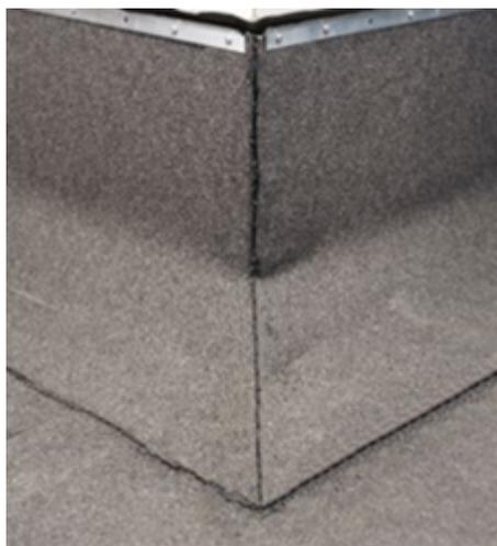
Наплавленный на вертикальную поверхность материал необходимо закрепить краевой рейкой при помощи остроконечных саморезов ТЕХНОНИКОЛЬ EDS-S 4,8 мм с полиамидной гильзой. Зазор между стеной и отгибом краевой рейки необходимо заполнить Мasticой герметизирующей ТЕХНОНИКОЛЬ № 71.
