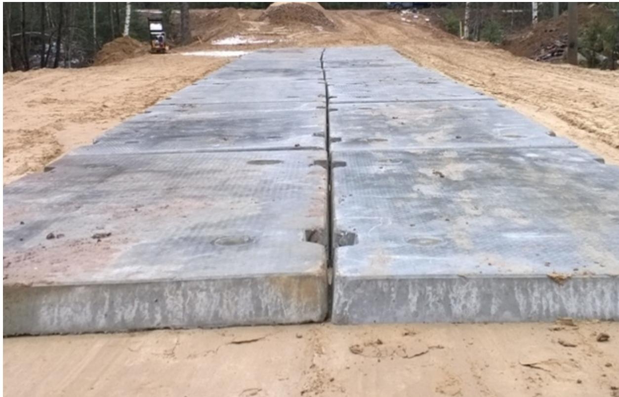
Полы сборного типа собираются непосредственно на месте. В большинстве случаев их используют, когда пол выполняется в виде простых геометрических форм.
