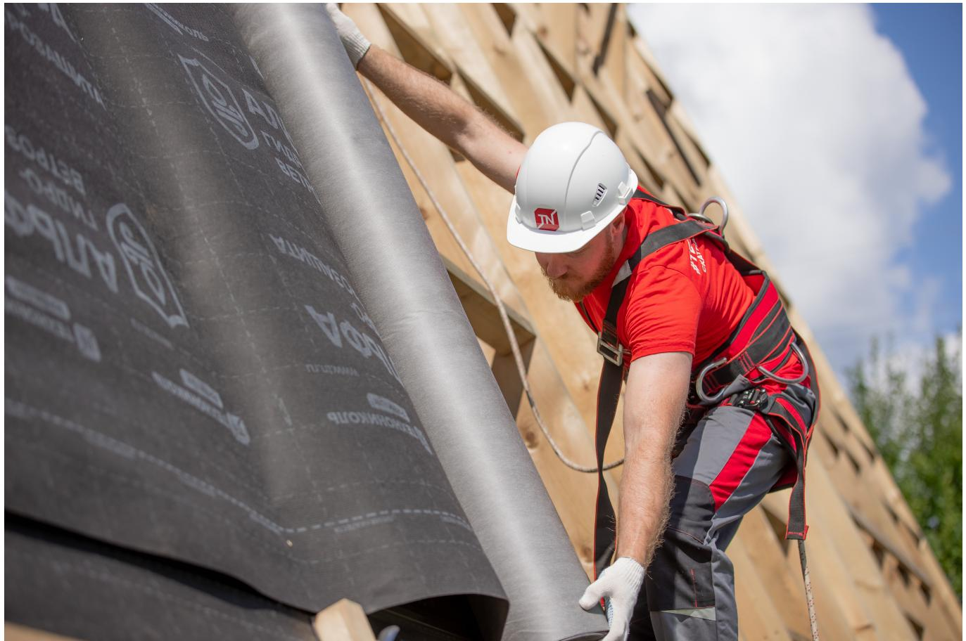
Далее мембрану фиксируют контрбруском, который также служит для создания вентканалов, на контрбрус монтируется разреженная обрешетка. Между мембраной и бруском необходимо уложить уплотнительную ленту АЛЬФА КОНТРБРУС.
