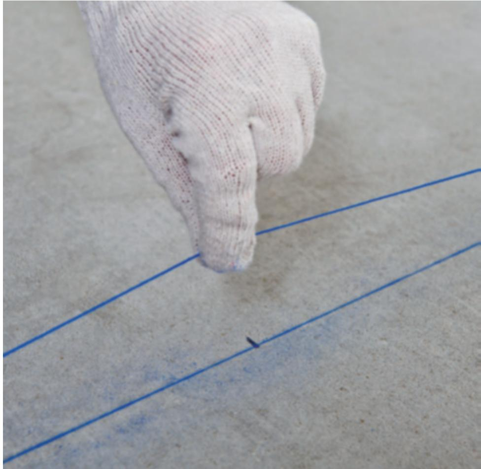
Разметку необходимо выполнить на полу, стенах и потолке, согласно проекту будущей перегородки. Для соединения точек и выполнения разметки следует использовать отбивочный шнур. Разметку пола и перенос отметок надлежит осуществить также с помощью отбивочного шнуря.
