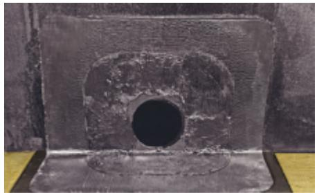
Установите наклонные бортики (ТЕХНОРУФ В60 ГАЛТЕЛЬ) к парапетной воронке на горячую мастику. Создайте плавный переход от наклонной поверхности бортика к вертикальной поверхности дополнительного слоя.
