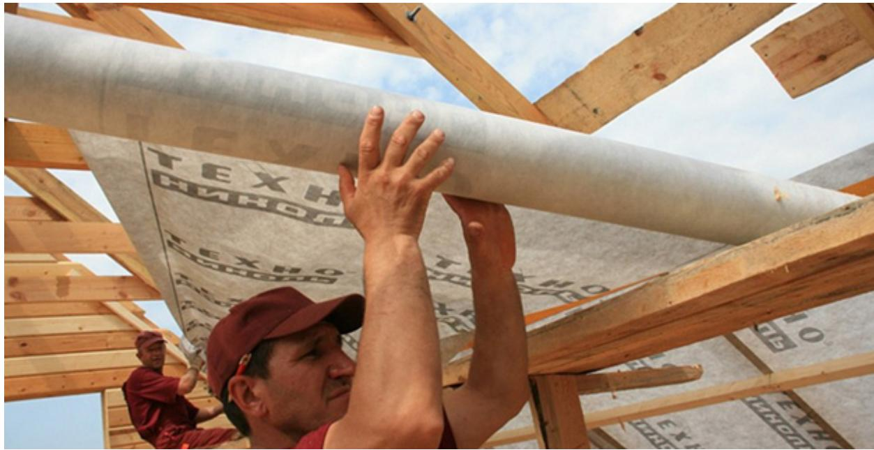
Далее начинаем закреплять пароизоляционную мембрану деревянными планками, так чтобы она обязательно находилась с внутренней стороны, также защищая от влажного пара несущие деревянные конструкции.
