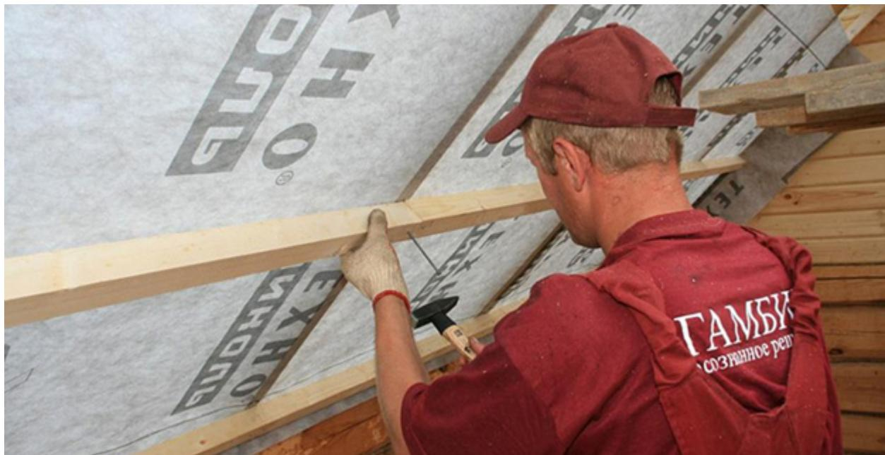
Планка — деревянный брус, так же нужен для крепления внутренней обшивки мансарды из листов гипсокартона или плит ОСП. Устанавливаем ее по всей длине с шагом 600 мм.
