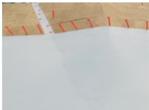
С помощью ручной сварки приварите основной гидроизоляционный ковер к предварительно закрепленной полосе мембранны.
