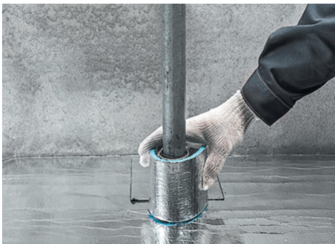
Обверните металлическую гильзу самоклеящейся демпферной лентой.
