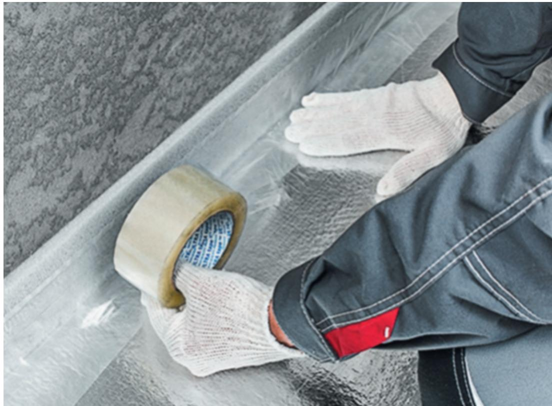
Для предотвращения попадания ц/п раствора под демпферную ленту проклейте место сопряжения с материалом скотчем или самоклеящейся лентой-герметиком ТЕХНОНИКОЛЬ.
