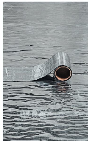
**ВАЖНО!** Проклейка лентой-герметиком предохранит уложенные материалы от смещения при последующем монтаже напольного покрытия и от образования звуковых мостиков вследствие возможного попадания цементно-песчаного раствора в боковые и торцевые стыки соседних полотнищ.
