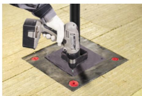
Для создания герметичного соединения необходимо обмазать фланец стакана битумным вяжущем.
