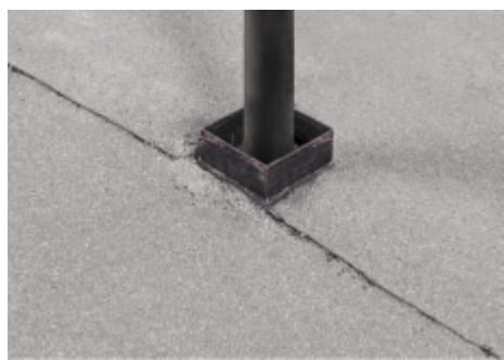
Полость между трубой и стенками стакана заполнить герметиком 2К или горячей мастикой.
