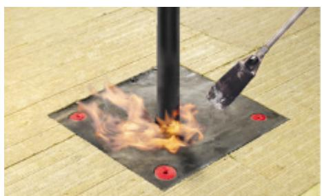
Установите стакан и вдавите фланец в разогретый материал. Следите за равномерным вытеком битумно-полимерного вяжущего из-под фланца стакана. Вытек обесует полную
