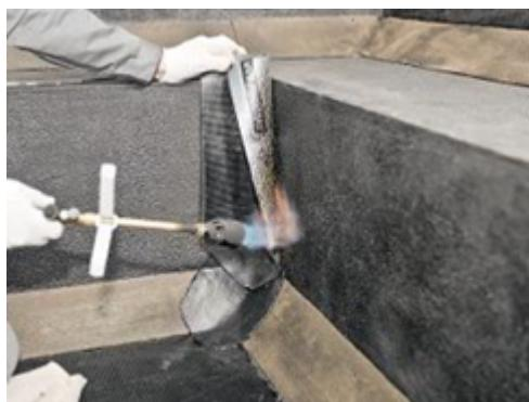
Затем наплавьте вторую сторону элемента усиления.
