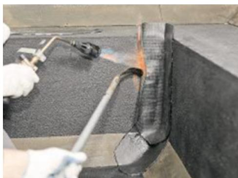
Тщательно проплавьте нижнюю часть элемента усиления в месте перехода.
