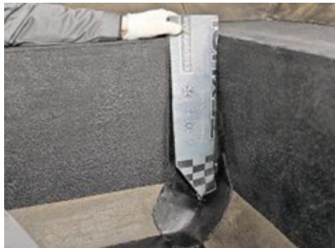
Наплавьте сначала одну сторону элемента усиления.
