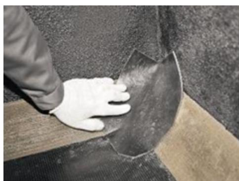
Наплавьте элемент усиления.
