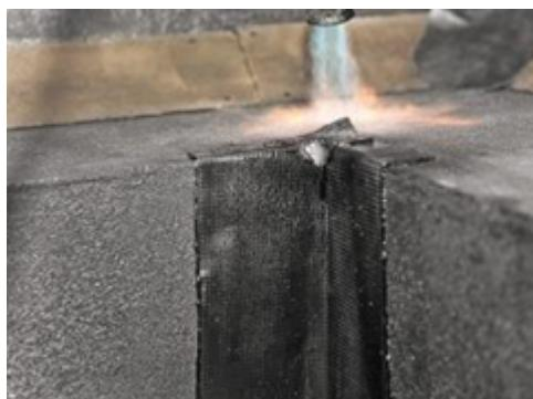
Готовый элемент усиления должен выглядеть следующим образом.
