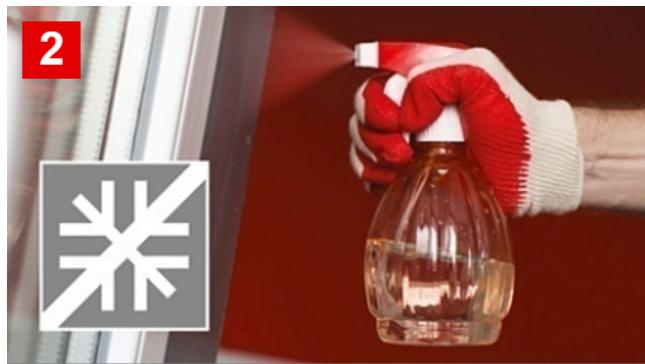
**ВАЖНО!** При чрезмерном увлажнении - монтажная пена может дать большую усадку.
