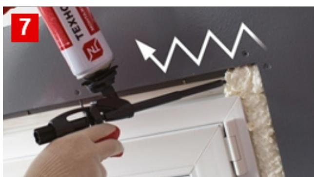
8. При заполнении вертикальных щелей пену наносят снизу вверх (в таком случае еще жидкой пены будет на чем держаться).
