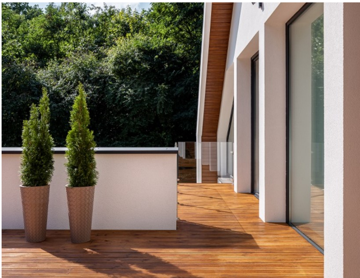
Покрытие кровли первого этажа террасной доской
