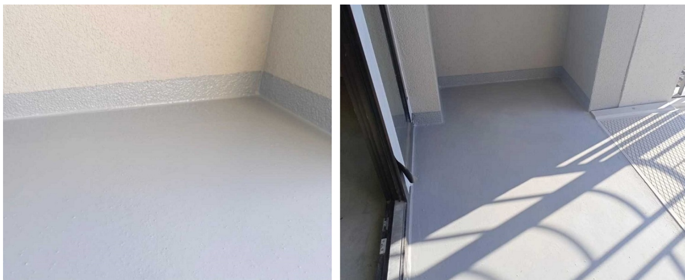
Фото 2. Система гидроизоляции ТН-ПОЛ ТАЙКОР Балкон на объекте.
