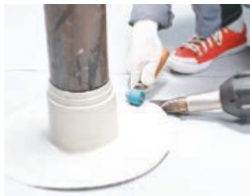
Затяните место примыкания металлическим хомутом.
