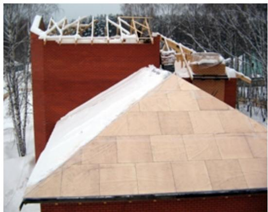
Шаг и сечение стропил определяют расчетом в зависимости от действующих нагрузок. В зависимости от шага стропил применяется различная толщина сплошного деревянного настила.
