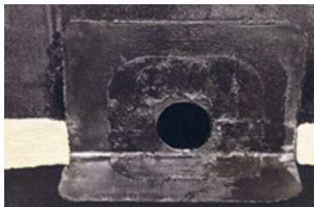
13. Наплавьте полосы слоя усиления из материала Техноэласт ЭПП на переходной бортик.
