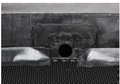
18. Наплавьте нижний дополнительный слой материала Техноэласт ЭПП на парапет так, чтобы
