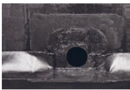
14. Наплавьте нижний слой из материала Техноэласт ЭПП. Материал подведите к наклонному
