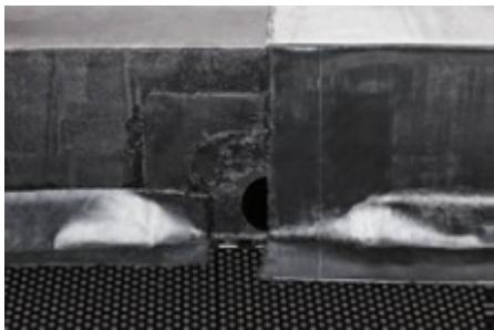
19. Прорежьте кровельный ковер по отверстию трубы водоприемной воронки.
