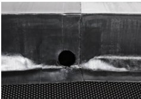
20. Наплавьте верхний слой из материала Техноэласт ЭКП.
