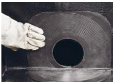
Следите за равномерным вытеком вяжущего из-под фланца воронки.
