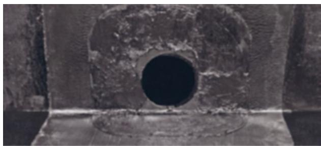
12. Установите наклонные бортики ТЕХНОРУФ В60 ГАЛТЕЛЬ к парапетной воронке на горячую мастику. Создайте плавный переход от наклонной поверхности бортика к вертикальной поверхности дополнительного слоя.
