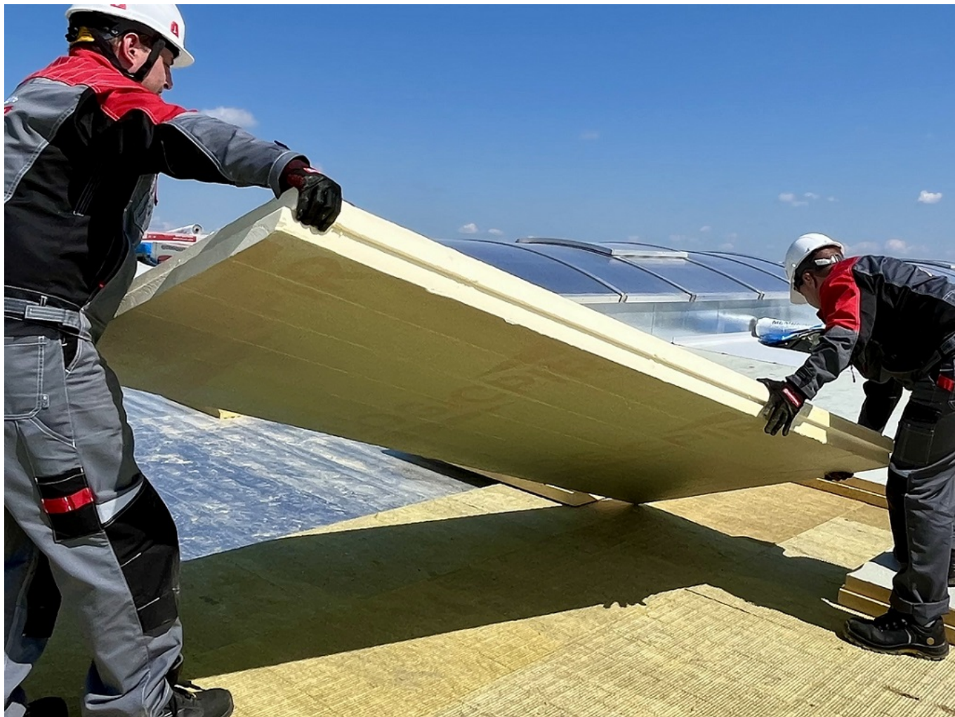
L-образная кромка на краях плит LOGICPIR повышает эффективность теплоизоляции
