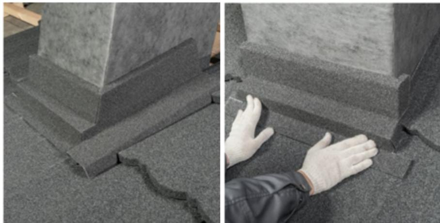
Примыкание к стене является частным случаем примыкания к трубе и выполняется аналогично.
