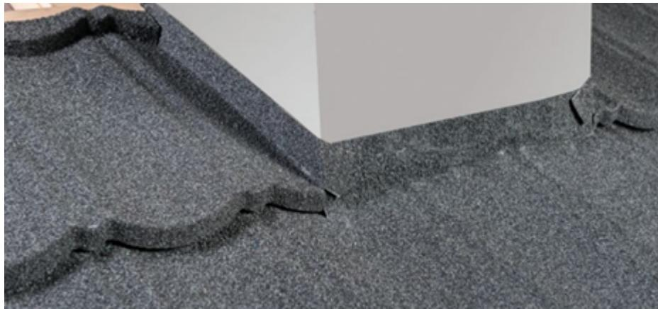
Элементы панелей, которые монтируются снизу по углам трубы, обрежьте под 45 градусов. Часть панели отогните вверх. Композитную черепицу, примыкающую к боковым частям трубы, загните в месте стыка трубы и ската.
