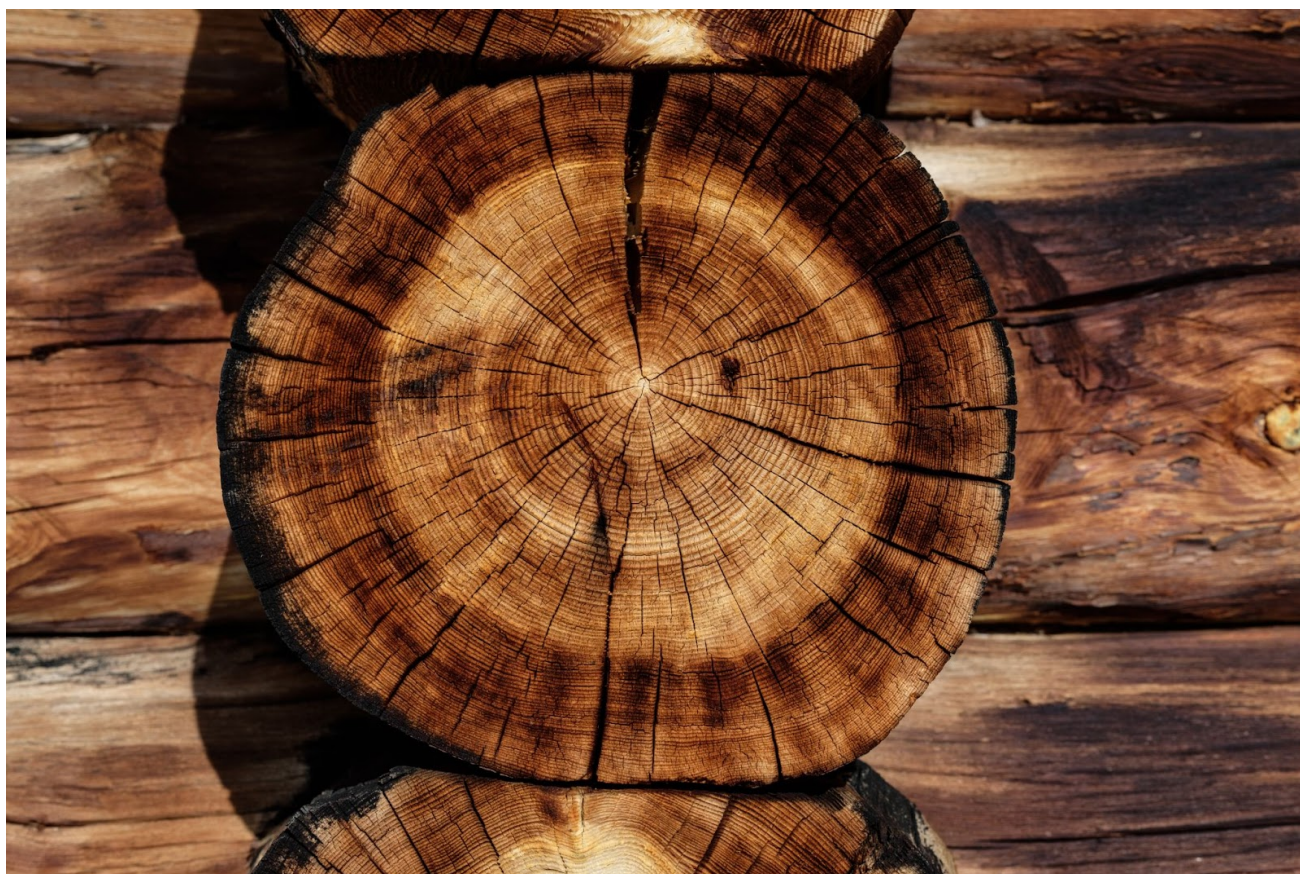
Трещины в бревне от напряжения изнутри
