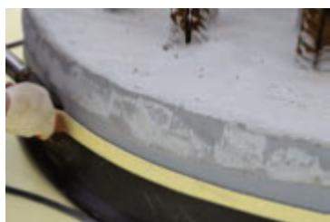
Приварите сформированный ранее «отворот» к уже смонтированной по горизонтальной поверхности мемbrane.
