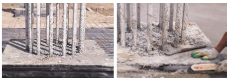
Уложите подстилающий слой геотекстиля на поверхность бетонной подготовки. Край геотекстиля не должен попадать на поверхность шпонки.
