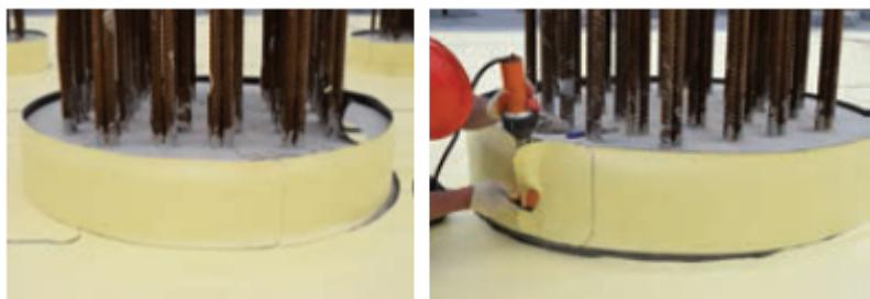
Сформируйте «отворот» нижнего края устанавливаемой полосы для формирования ее нахлеста на уже смонтированной по горизонтальной поверхности мембраны.
