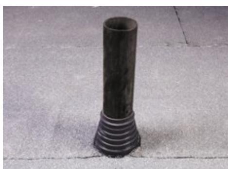
Для герметизации соединения между трубой и уплотнителем нанесите Мастику
