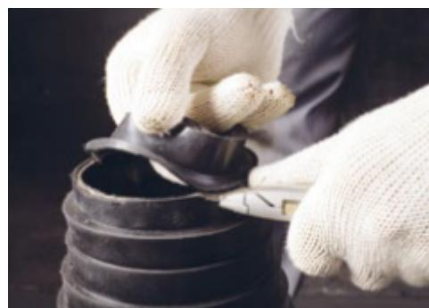
Обожгите пленку на поверхности материала. При использовании в качестве материалов нижнего слоя тонких наплавляемых материалов перед установкой фланца воронки необходимо обжечь пленку на материале и налить слой Мастики горячей ТЕХНОНИКОЛЬ № 41 («Эврика») или намазать шпателем Мастику герметизирующую ТЕХНОНИКОЛЬ № 71.
