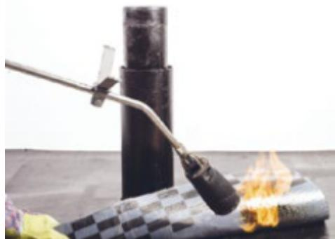
Наплавьте верхний слой из материала Техноэласт ЭКП.
