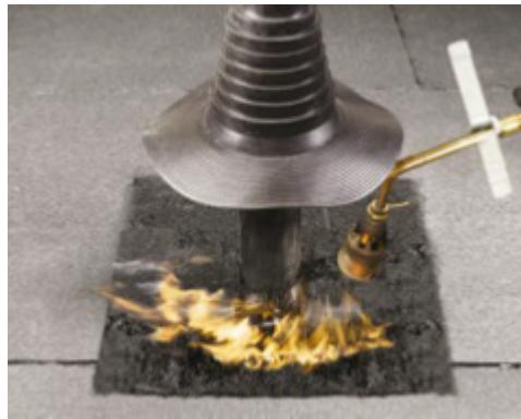
Для создания герметичного соединения необходимо обмазать юбку уплотнителя битумным вяжущем.
