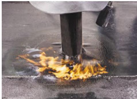
Вдавите юбку в разогретый материал. Следите за равномерным вытеком битумно-полимерного вяжущего из-под юбки уплотнителя. Вытек обесуетит полную герметичность соединения.
