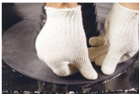
Для создания герметичного соединения необходимо обмазать юбку уплотнителя битумным вяжущем.
