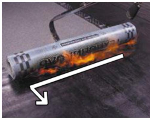
Для качественного наплавления материала на основание необходимо добиться небольшого валика битумно-полимерного вяжущего в месте соприкосновения материала с поверхностью.
