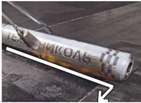
Деформация рисунка свидетельствует о правильном разогреве битумно-полимерного вяжущего с нижней стороны рулонного материала.
