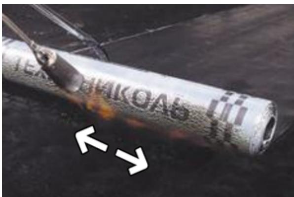
**Важно! При устройстве кровель по теплоизоляционным плитам, нагрев поверхности основания не требуется. Наплавление материала производится при пониженном давлении газа до 1-1,2 атм (до 1,0-1,2 кгс/см<sup>2</sup>). Пламя горелки направляется только на поверхность рулона. Длина пламени от места выхода из горелки до рулона не более 300-400 мм.**
