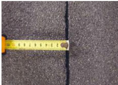
**Важно! Вытек более 25 мм вдоль всего продольного нахлеста свидетельствует о перегреве материала. Перегрев при наплавлении ухудшает эксплуатационные свойства кровли.**
