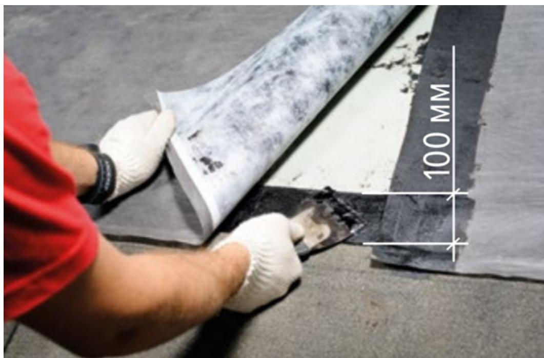
Следует обращать внимание на расстояние между торцами соседних полотен. Торцевые нахлести соседних полотен материала должны быть разнесены минимум на 500 мм.
