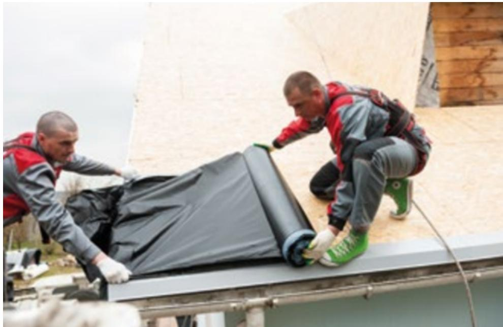
При температуре ниже +5 °C необходимо дополнительно закрепить подкладочный ковер вдоль верхней горизонтальной кромки при помощи кровельных гвоздей с отступом от края ковра 50 мм с шагом 300 мм.
