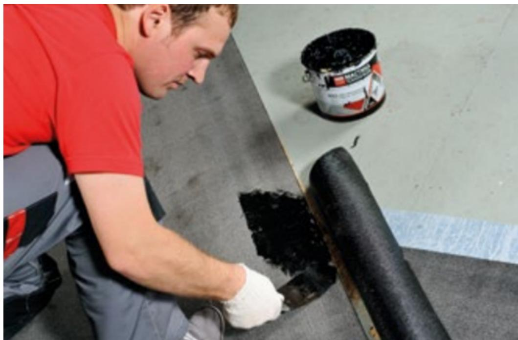
В поперечном направлении нахлест составляет 150 мм.
