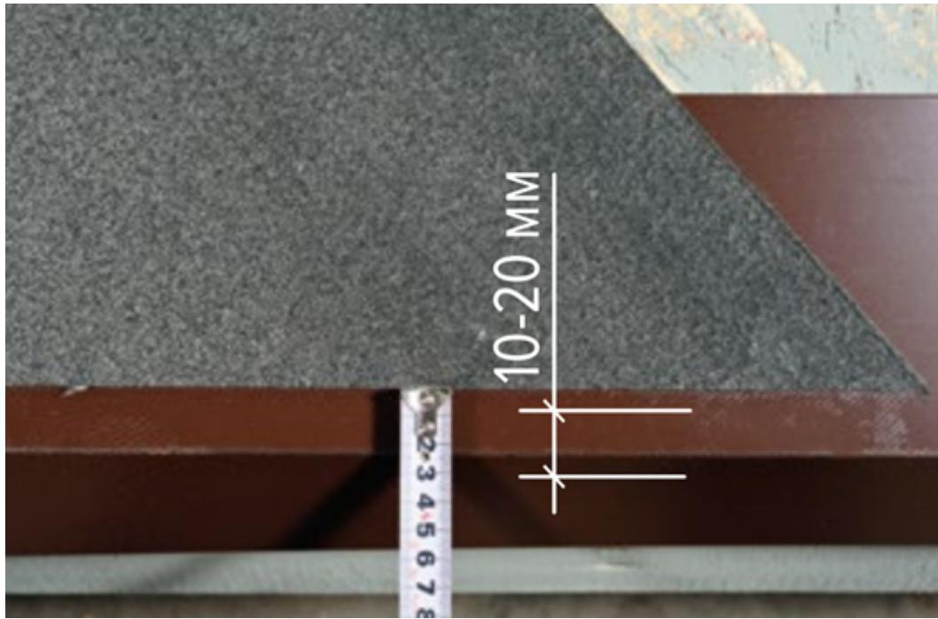
Снять защитную пленку, затем полностью приклейте полотно к основанию.
