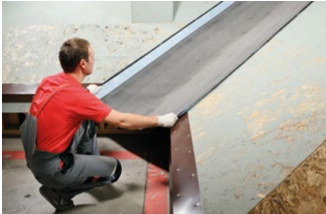
Произвести разметку, обрезать лишние части подкладочного ковра.
