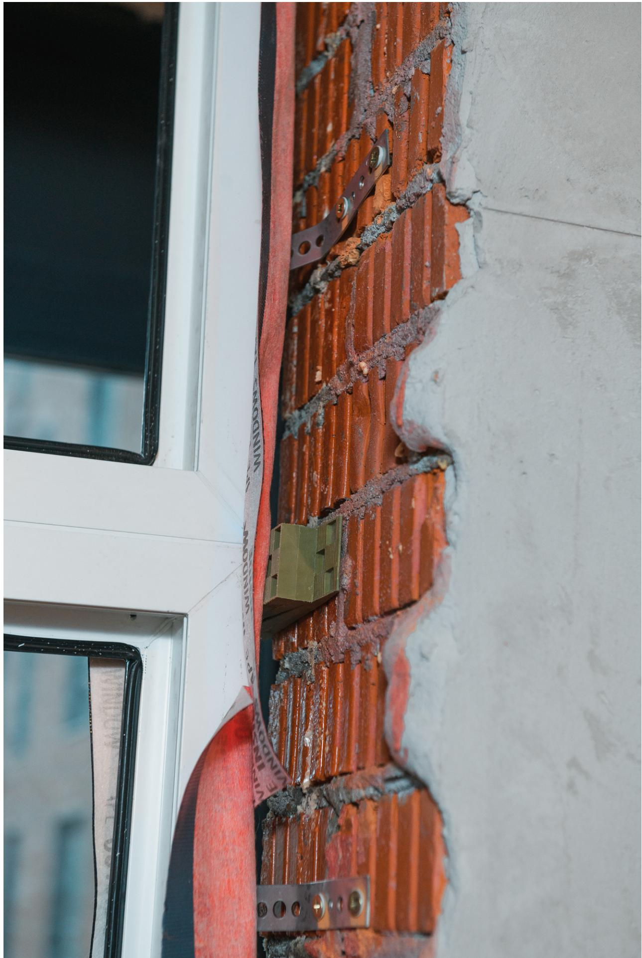
Стандарты на монтаж окон устанавливают требования к ширине швов относительно материала оконного блока (Таблица 2.). Требования обусловлены возникающими в оконной конструкции температурными деформациями. При слишком малой ширине шва окно будет выдавливать из проёма, а при слишком большой снижаются теплоизоляционные характеристики шва.
