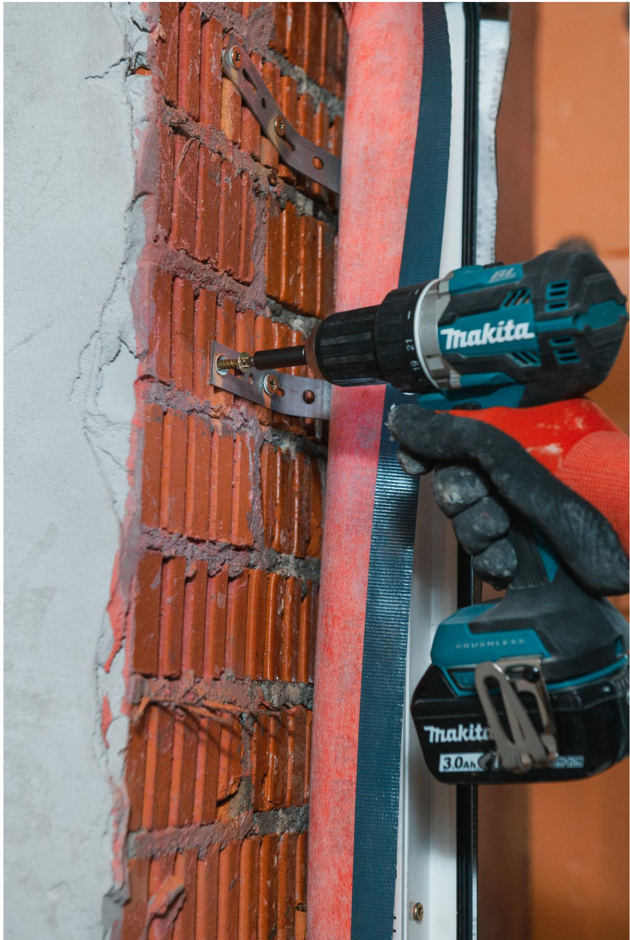
Опорные колодки устанавливаются под вертикальными брусками оконного блока и импостным соединением, а также под всем нижним профилем с шагом не менее 300 мм. Интервалы расположения крепежных элементов установлены приведены в таблице 1.
