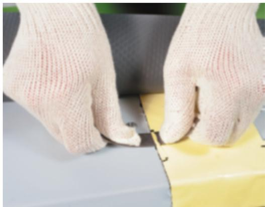
Приварите полосу к готовому элементу с помощью ручного фена.
