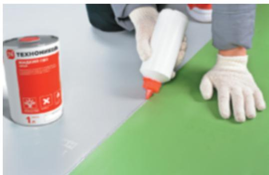
Нанесите жидкий ПВХ ТЕХНОНИКОЛЬ на все сварные швы примыкания к карнизу
