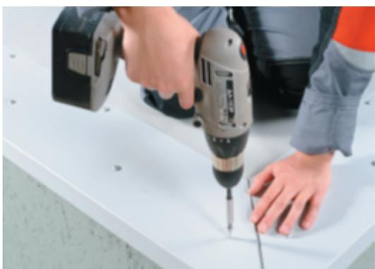
Оставляйте температурный зазор через каждые 3 м. Величина зазора должна составлять 3-5 мм. Выставив зазор, закрепите следующий капельник.
