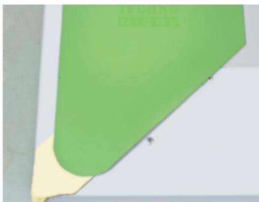
Со стороны кровли приварите полосу к основному кровельному коври с помощью автоматического оборудования горячего воздуха.
