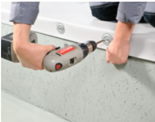
Разрежьте готовые капельники из ПВХ металла под углом 45° с помощью ножниц по металлу. Прикрепите капельники к основанию.
