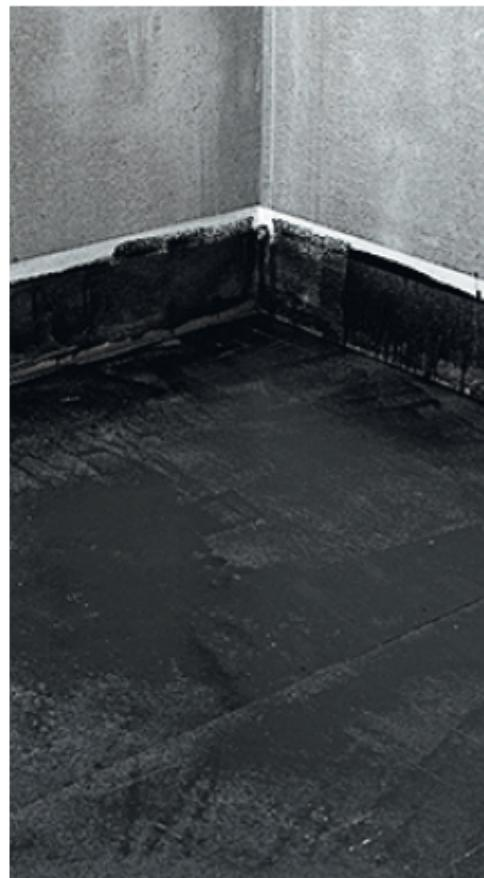
Праймер наносится с помощью щетки или валика по всей поверхности предстоящей укладки материала, в том числе и вертикальной.
