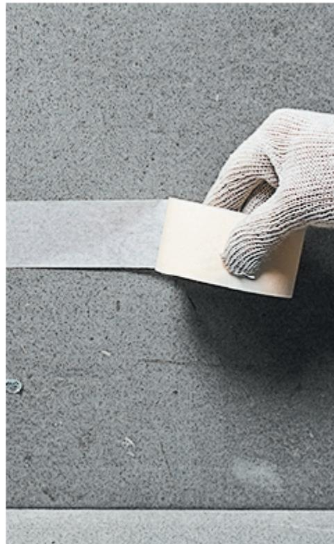
Основание для укладки материала ТЕХНОЭЛАСТ БАРЬЕР (БО) или ТЕХНОЭЛАСТ БАРЬЕР ЛАЙТ обработайте праймером ТЕХНОНИКОЛЬ №04
