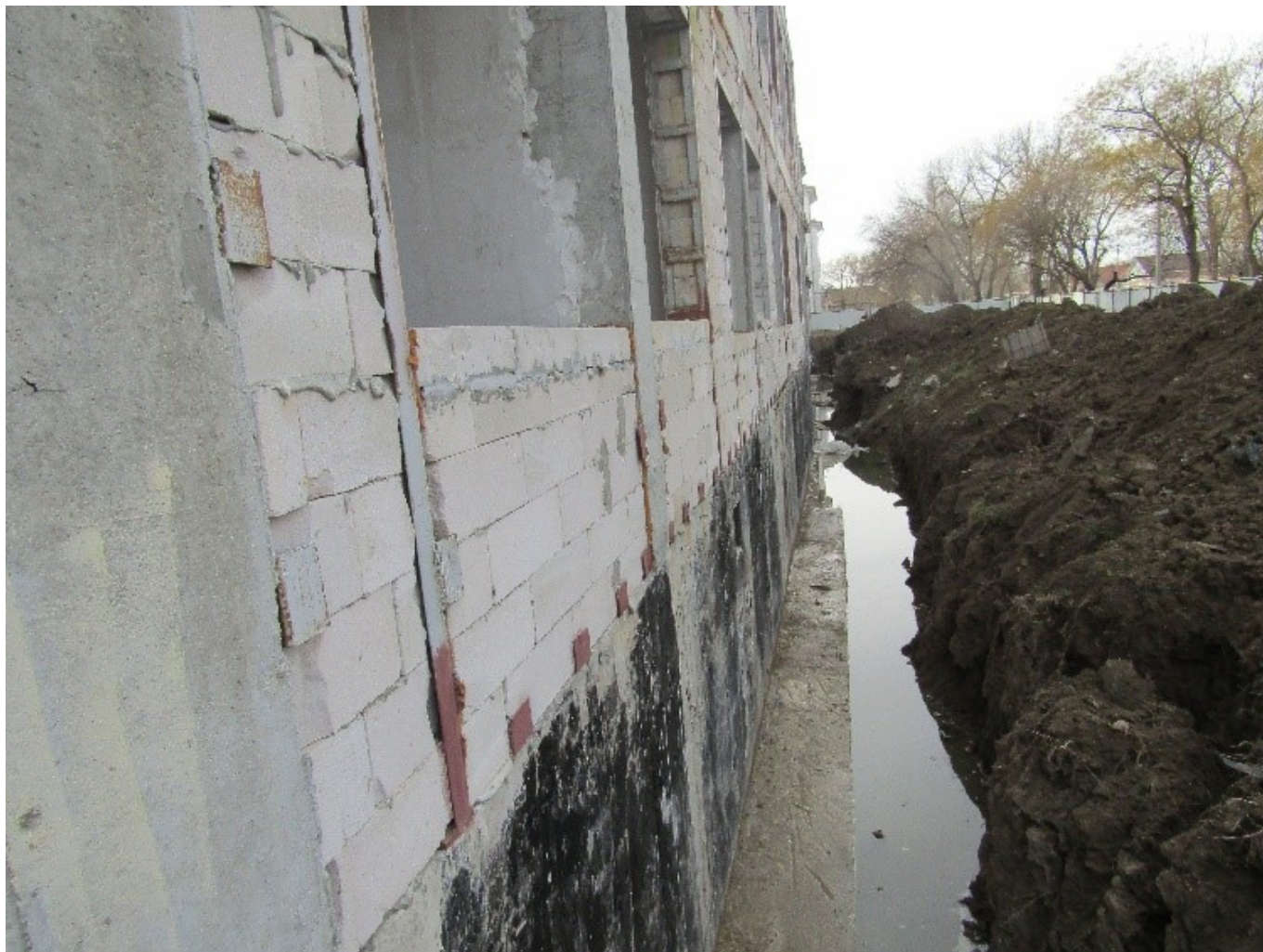
Рис. 2. Затопление цокольной зоны строящегося здания.
