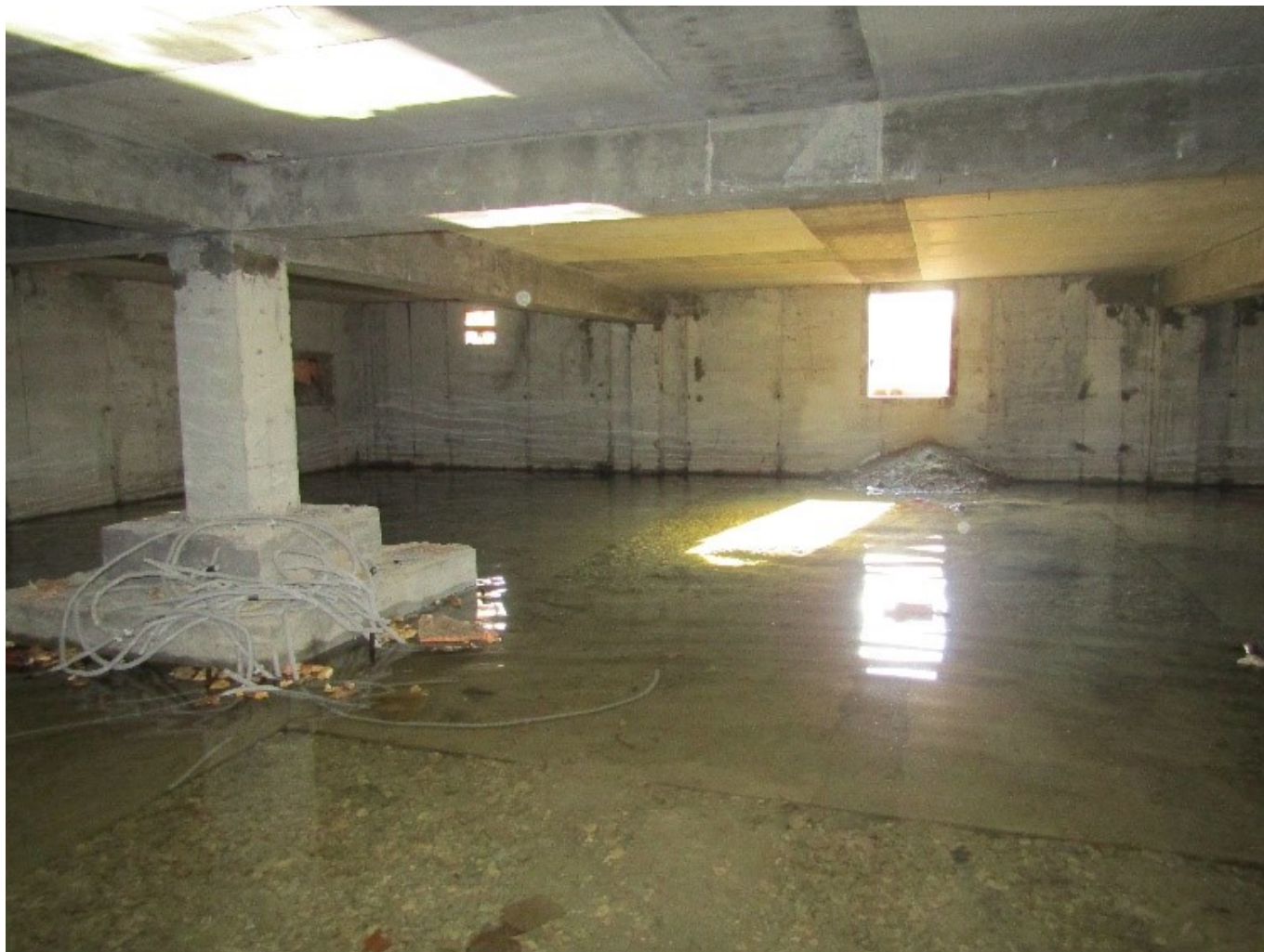
Рис. 1. Затопление подвала строящегося здания.
