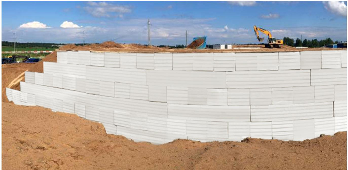
Облегченные насыпи представляют собой конструкции, в которых часть грунта заменяется на гораздо более легкий материал – экструзионный пенополистирол, что позволяет кратно снизить нагрузку на основание, повысить надежность и безопасность конструкции.
