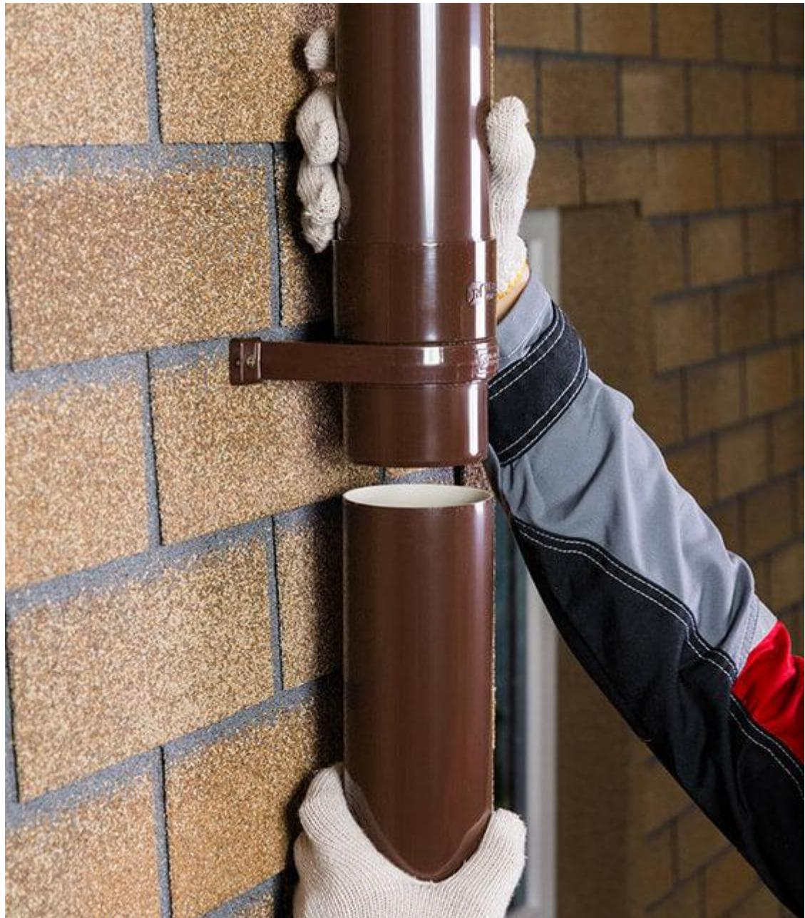
Установите водосточный слив на трубу и зафиксируйте его хомутом. При этом минимальное расстояние слива от грунта должно составлять не менее 150 мм от отмостки.
