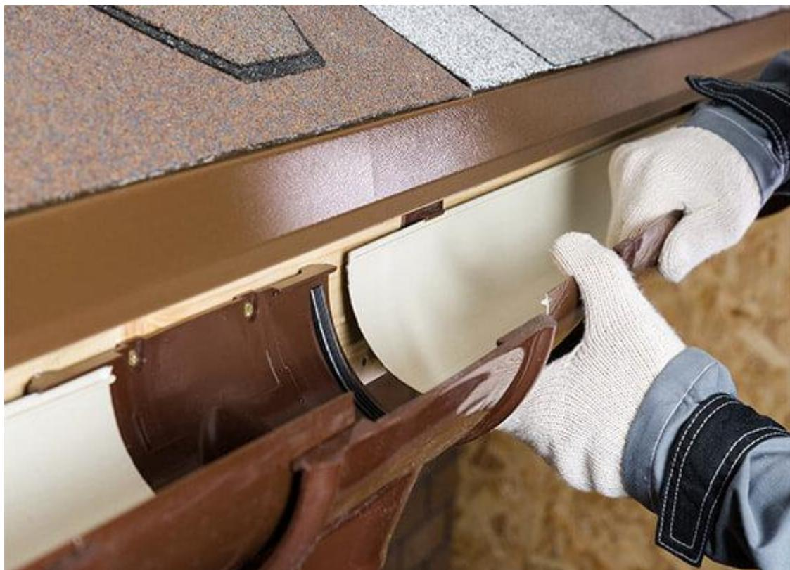
Установите водосточные жёлоба в кронштейны до защёлкивания с фиксирующими элементом кронштейна. Соединение жёлоба с кронштейном также необходимо производить в направлении «изнутри-наружу».
