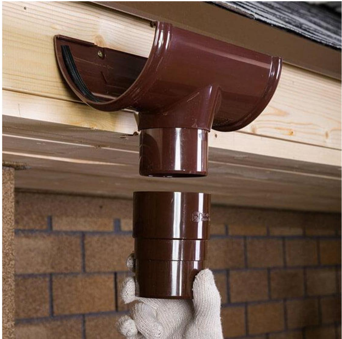
Водосточные трубы крепятся к основанию здания при помощи хомута крепления трубы. Шаг хомутов составляет не более 1,5 метров.
