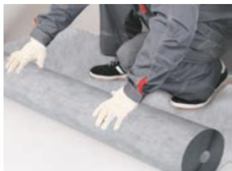
Во избежание расхождения полотен точечно скрепляйте нахлести горячим воздухом при помощи ручного сварочного фена. Выберите температуру 250–300 °С для точечной прихватки полотен.
