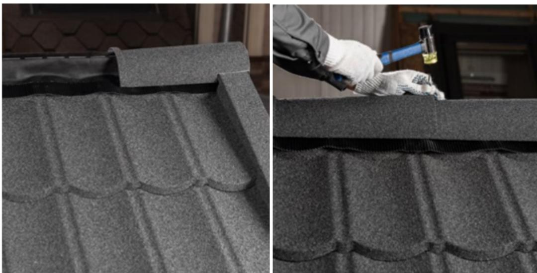
Коньковый брус сечением 50x50 мм (или 50x 75 мм) зафиксируйте саморезами к креплению конькового бруса. Верхний ряд панелей ската не является полноразмерным, поэтому подрежьте панель вдоль и спрофилируйте в тисках либо специальном станке опорную ступень для укладки на обрешетку. Фиксацию выкроенных панелей производите аналогично целым панелям.
