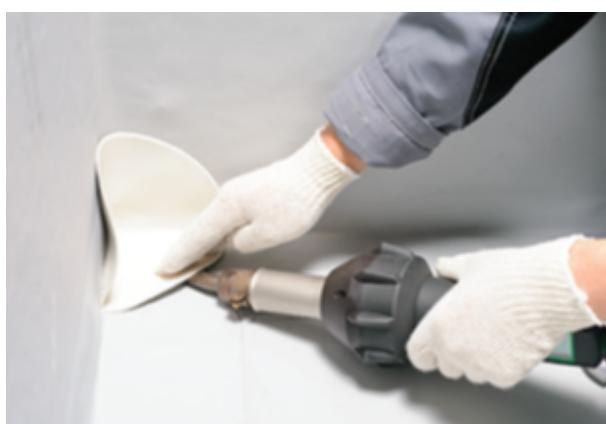
Доварите края элемента узким латунным роликом.
