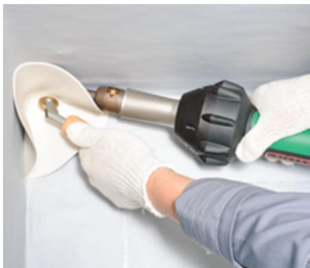
Выварите основную площадь готового элемента.
