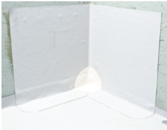
Зафиксируйте центр готового элемента.
