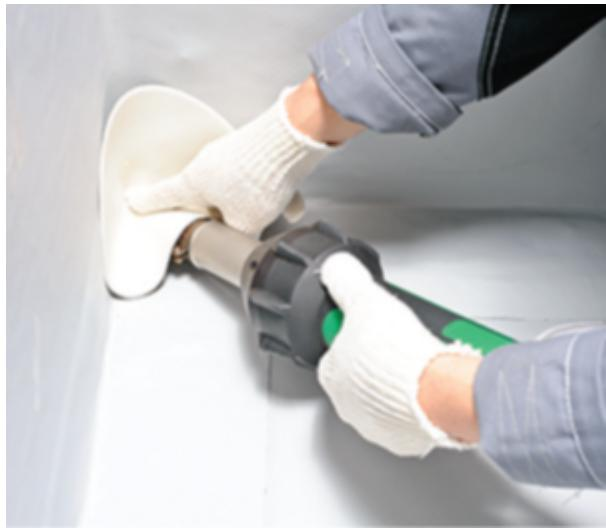
Проварите радиусы элемента с помощью латунного ролика.
