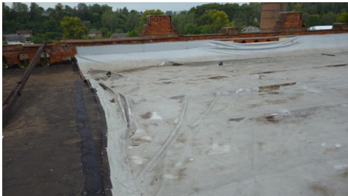
От расчета ветровой нагрузки сильно зависит количество крепежных элементов и ширина рулонов мембраны. Чем выше ветровая нагрузка, тем больше нужно крепежей на 1 м<sup>2</sup>, при этом ширину мембраны необходимо уменьшать, чтобы нужное количество крепежа можно было поместить в шов мембраны. Из-за этого вырастает коэффициент расхода.
