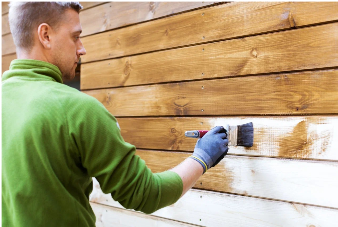
Пропитка деревянных панелей маслом для наружных работ
