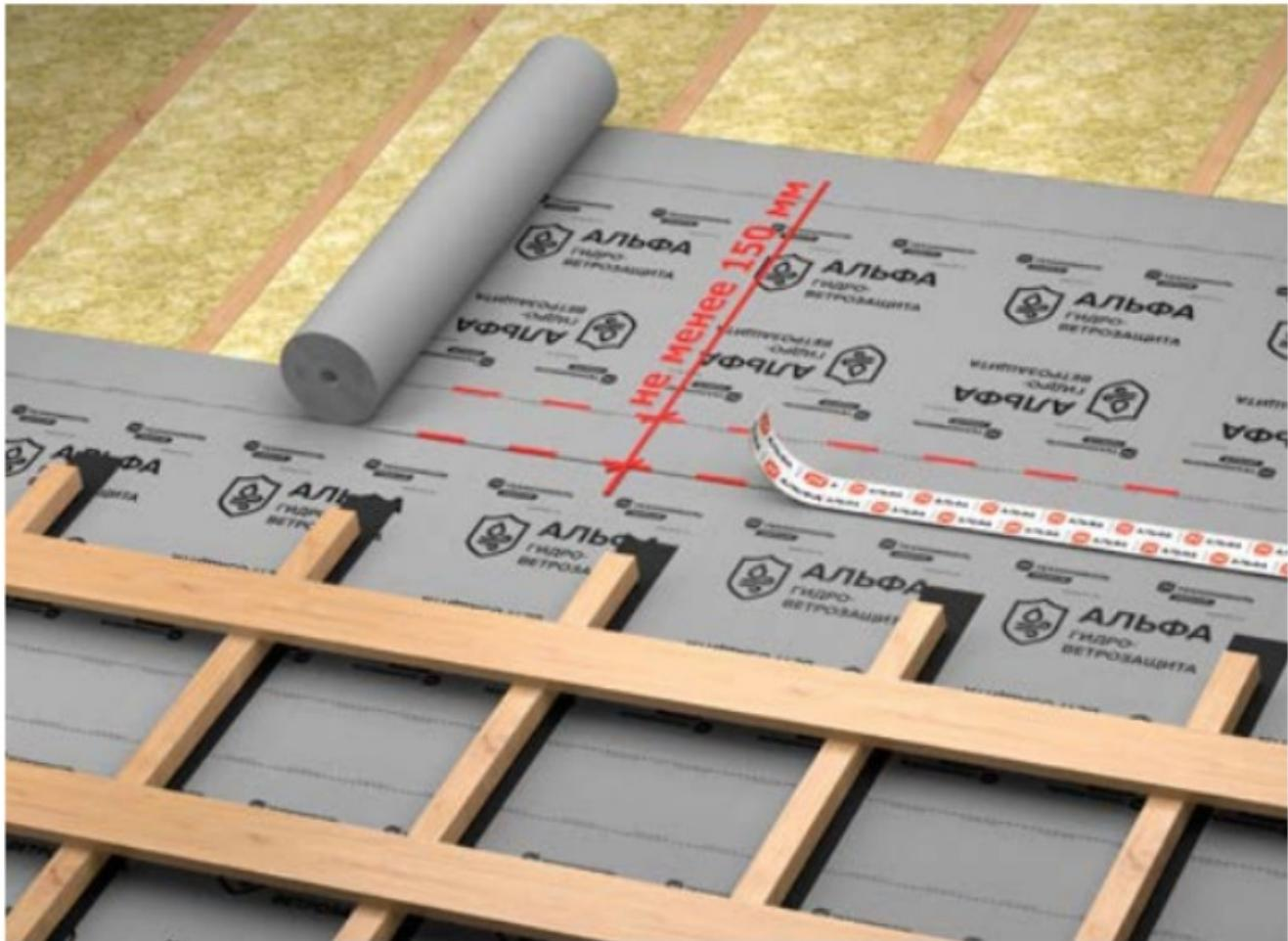
4. **Крепление мембраны:** материал предварительно закрепляется специальными нержавеющими скобами с широкой спинкой. Шаг крепления — 200 мм. Затем окончательно фиксируется рейками/бруском, установленными вдоль стропил (прогонов) и закреплёнными оцинкованными гвоздями длиной 100 мм с шагом 300–350 мм.
