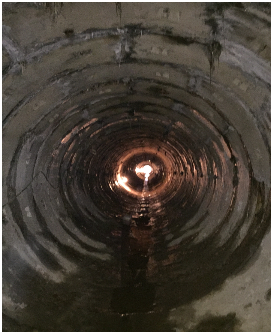
б) смонтированная полимерная рулонной гидроизоляция
