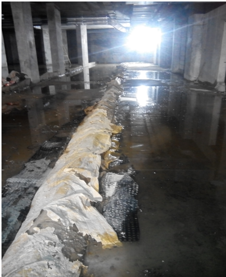
Рис. 1,2 Пример многоосного растяжения от негативного давления воды на гидроизоляционный материал, размещенный в области деформационного шва в конструкции фундамента.
