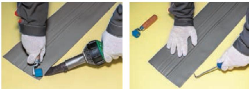
После остывания шва проверьте его герметичность. Проведите вдоль него пробником или шлицевой отвёрткой. В случае выявления негерметичных отрезков проведите их повторную сварку.
