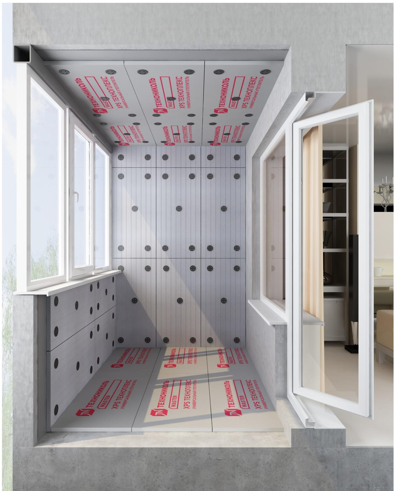
**5.** После дюбелирования производится нанесение базового штукатурного слоя, толщиной не менее 6мм. Выравняйте зубчатым шпателем нанесенную смесь и утопите в нее стеклосетку ТЕХНОНИКОЛЬ 2000 при помощи гладкого шпателя, равномерно распределяя смесь.
