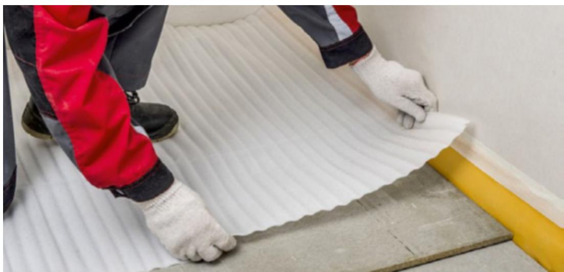
Далее производим монтаж планок ламината. Торцевые части звукоизоляционных плит ТЕХНОФЛОР СТАНДАРТ, оставленные после укладки пола по периметру помещения подрезаются при помощи ножа.
