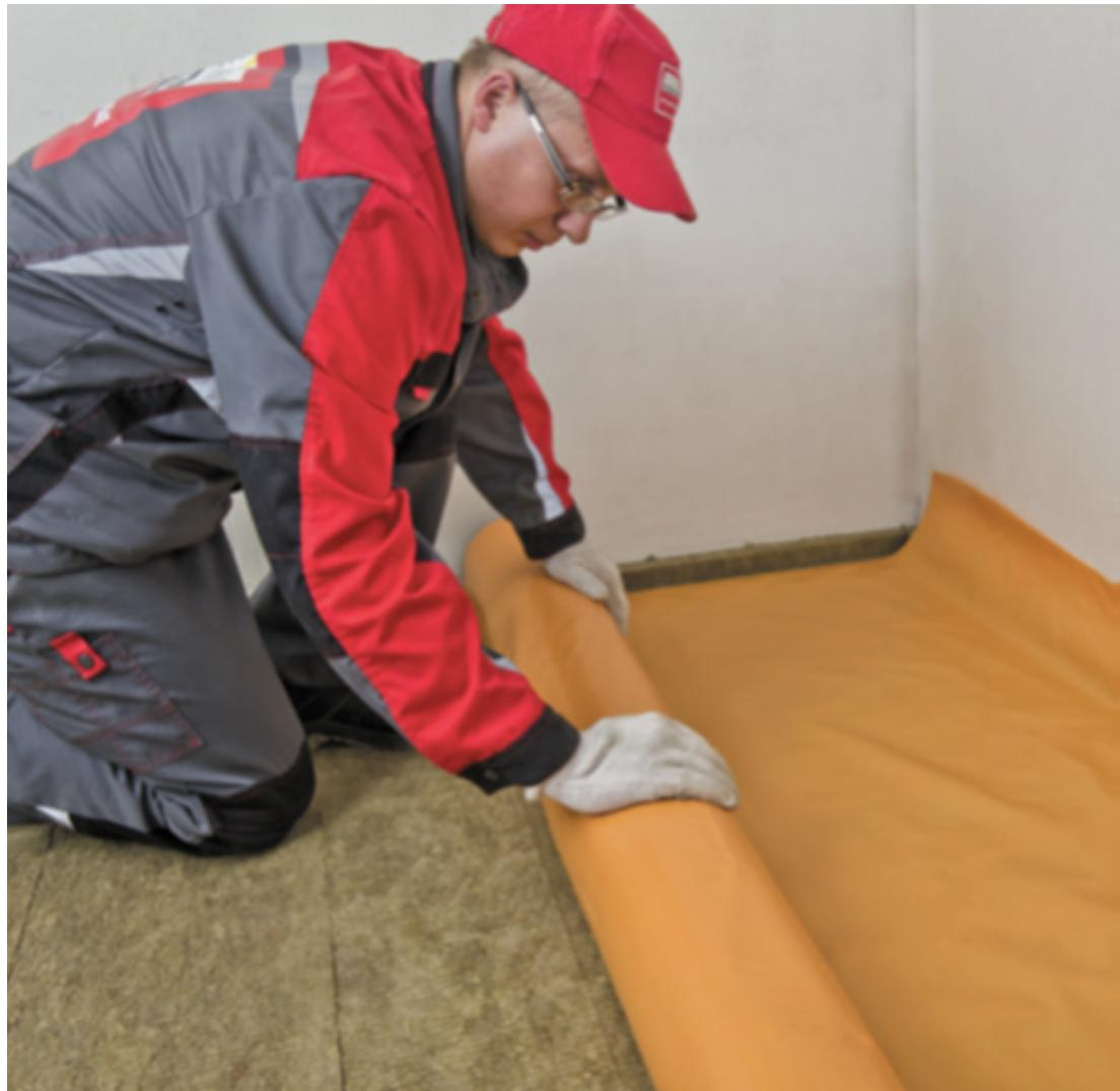
Уложить влагозащитную полиэтиленовую пленку поверх плит с нахлестом на стены и перехлестом полотен между собой 100–150 мм.
