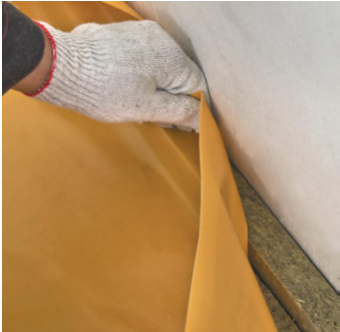
Пароизоляцию следует завести на высоту стяжки и закрепить к стене с помощью скотча. Особенно это касается мокрой стяжки, чтобы избежать попадания влаги в слой теплоизоляции.
