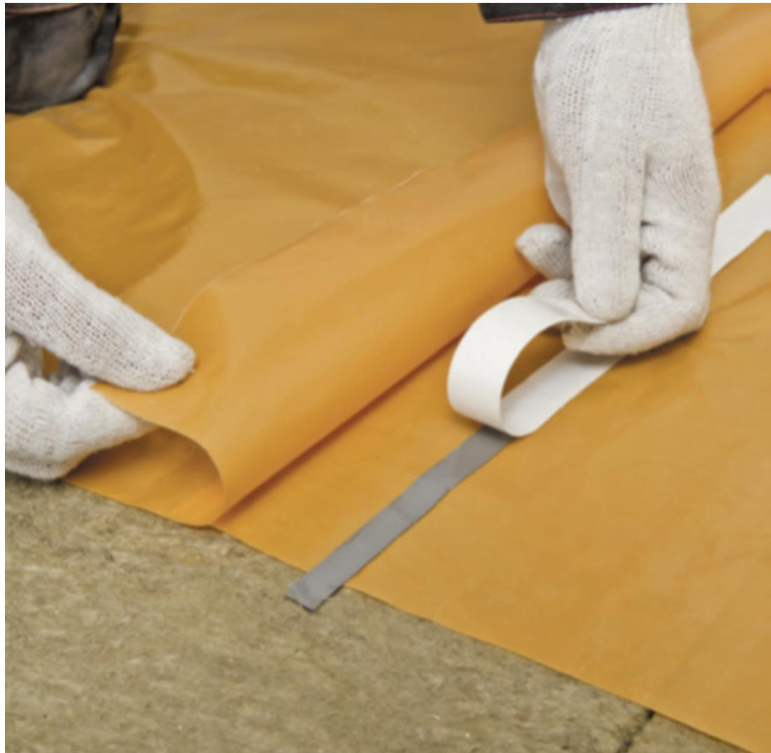
Проклеить стыки в местах перехлеста полотен пароизоляции.
