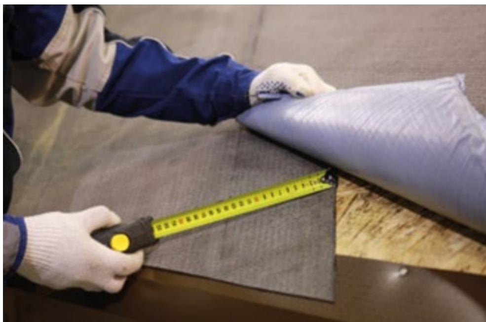
После примерки подкладочного ковра на карнизе снять защитную пленку с одной части полотна.
