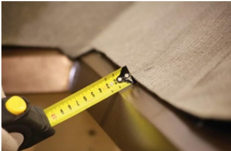
Укладку материала произвести с нахлестом в поперечном направлении 150 мм в месте сопряжения подкладочного ковра на карнизном свесе и ендовы, места нахлестов промазываются битумной мастикой ТЕХНОНИКОЛЬ ФИКСЕР толщиной не более 1 мм.
