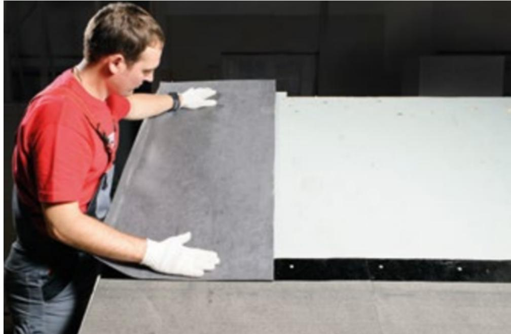
Так же, как и при монтаже самоклеящегося подкладочного материала, полотно подкладочного ковра примерить по месту.
