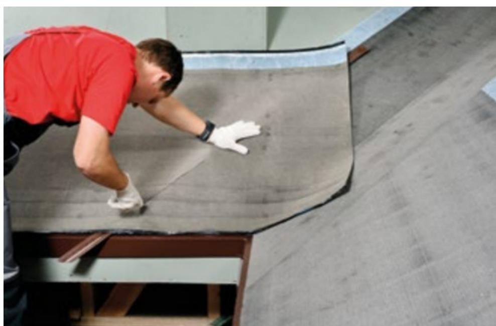
**ВАЖНО! При обрезке подкладывать под верхнее полотно жесткое основание (кусок дерева, фанеры и т.п.), чтобы избежать повреждения нижележащего полотна.**
