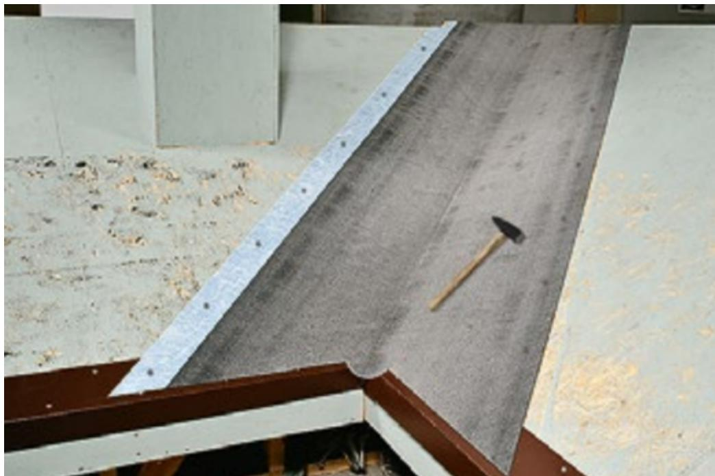
После укладки самоклеящегося подкладочного материала ANDEREP ULTRA в ендove необходимо смонтировать его на карнизном свесе.
