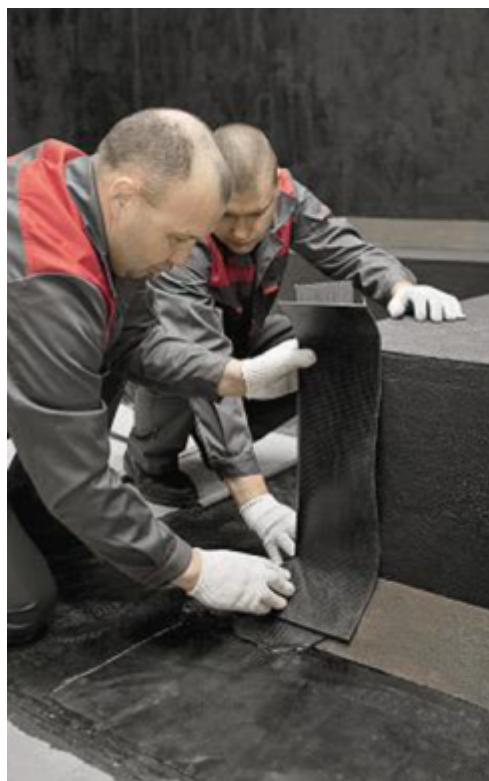
Наплавьте сначала одну сторону элемента усиления.
