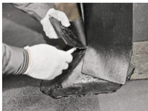
Наплавьте сначала одну сторону элемента усиления.
