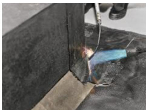
Завершите наплавление верхней части элемента усиления.
