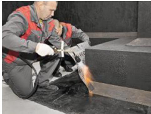
Затем наплавьте вторую сторону элемента усиления.
