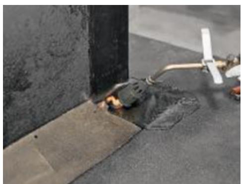
Готовый элемент усиления в месте перехода с фундаментной плиты на ограждающую конструкцию должен выглядеть следующим образом.
