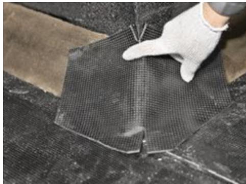
Выполните наплавление элемента усиления.
