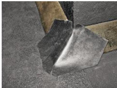
Выполните наплавление элемента усиления.
