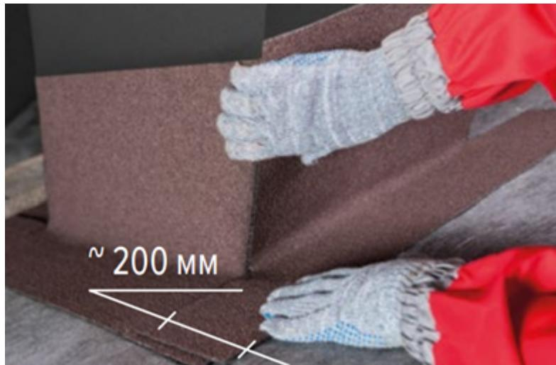
8. Произвести укладку гибкой черепицы. На левой и правой частях гибкая черепица заводится на выкройки из ендового ковра таким образом, чтобы желоб между черепицей и галтелью был шириной 80 мм.
