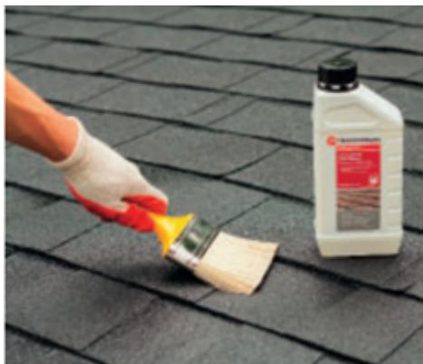
В профилактических целях обработку кровли проводят два раза в год - весной и осенью - в местах наиболее благоприятных для прорастания плесневых грибков, мха, лишайников, водорослей. Работы проводятся при любой температуре окружающей среды.
