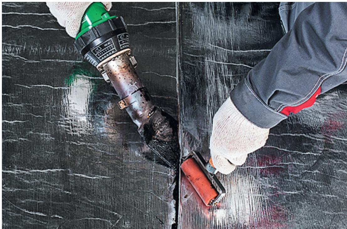
Одновременно разогревайте промышленным феном боковой шов и прокатывайте силиконовым роликом.
