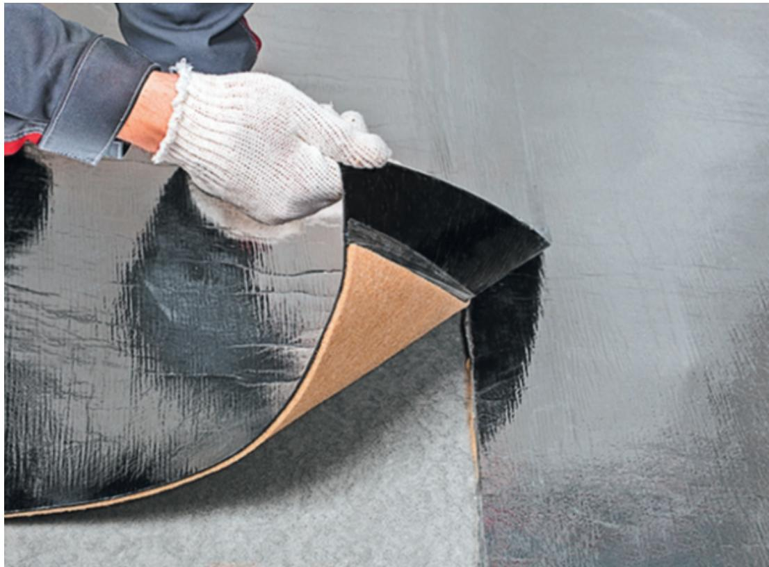
**ВАЖНО!** Очень важно состыковать материал, так чтобы звукоизоляционный материал оказался на всей плоскости перекрытия. Если этого не делать, то в конструкции будут образовываться звуковые мостики, через которые будет распространяться шум.
