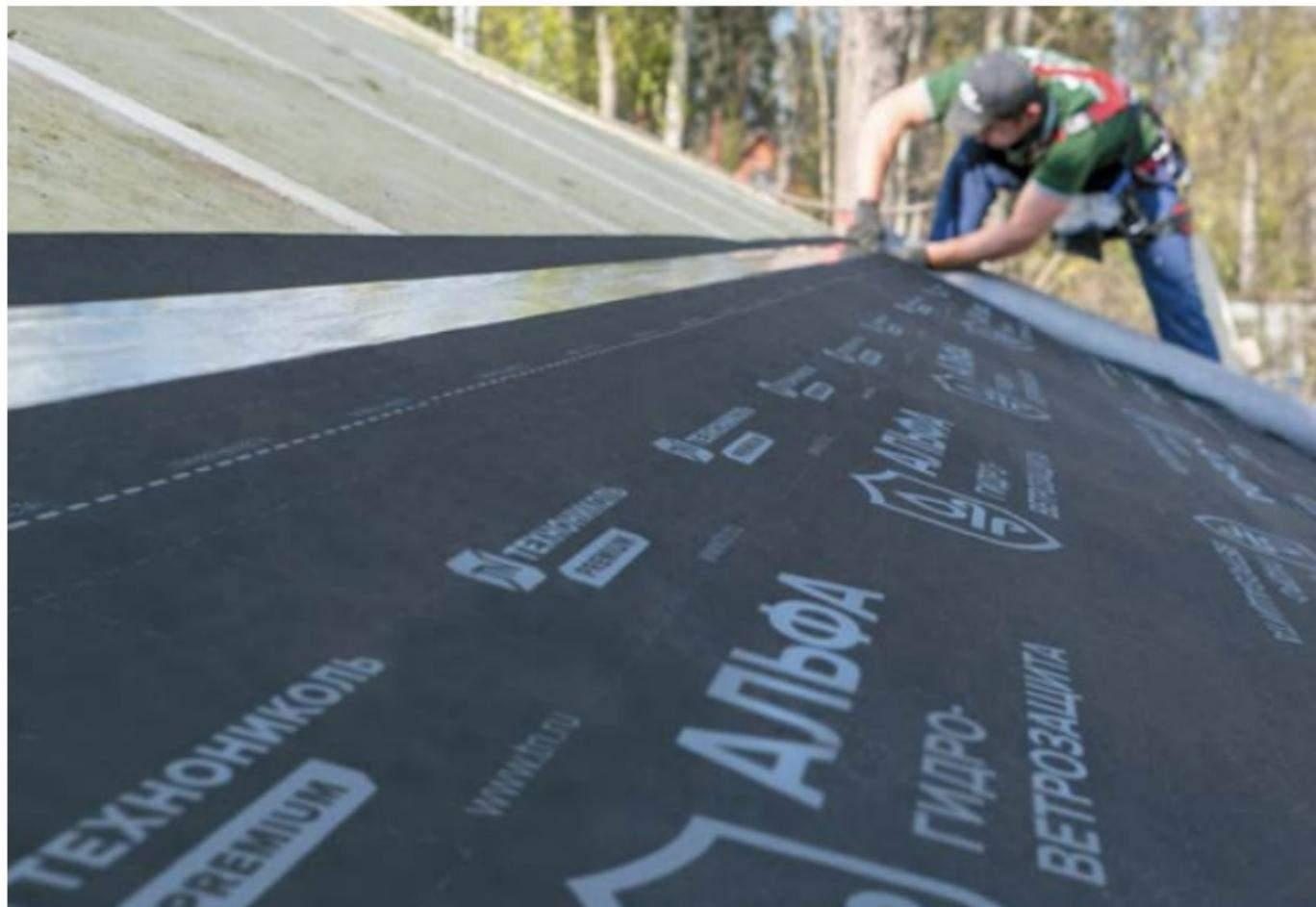
Гидроизоляция под металличерепицей — базовый этап при устройстве кровли, который защищает ее от возникновения конденсата, проникновения влаги в кровельную конструкцию.
