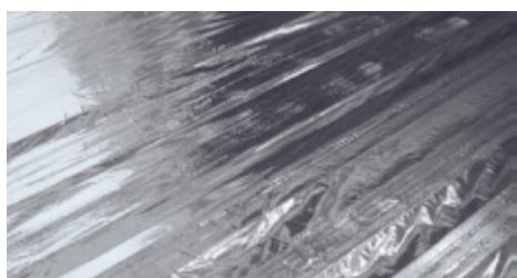
Прорежьте пароизоляцию по диаметру трубы воронки.
