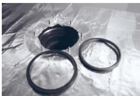
Для повышения герметичности соединения фланца с пароизоляционным материалом нанесите герметизирующую мастику ТЕХНОНИКОЛЬ №71. Мастику удобнее наносить змейкой из картриджа.
