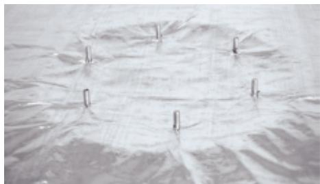
Прорежьте пароизоляцию по внутреннему диаметру воронки.
