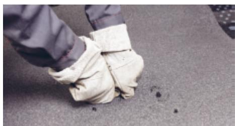
Прорежьте кровельный ковер по диаметру трубы водоприемной воронки.
