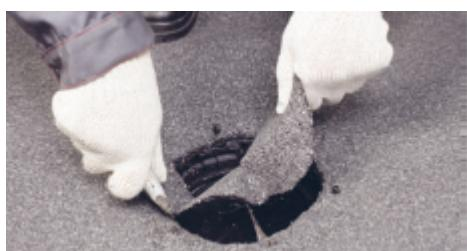
Для повышения надежности соединения фланца с кровельным ковром, нанесите Мастику герметизирующую ТЕХНОНИКОЛЬ № 71 на фланец с обратной стороны.
