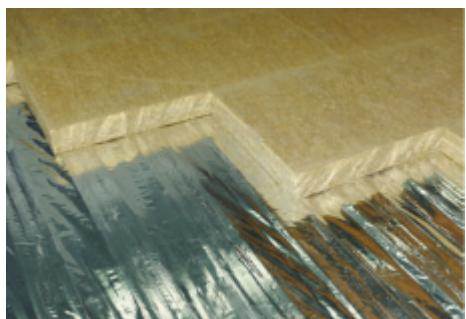
В месте установки воронки на участке не менее 500×500 мм, замените полностью утеплитель из каменной ваты ТЕХНОРУФ на экструзионный пенополистирол ТЕХНОНИКОЛЬ CARBON PROF (далее по тексту XPS).
