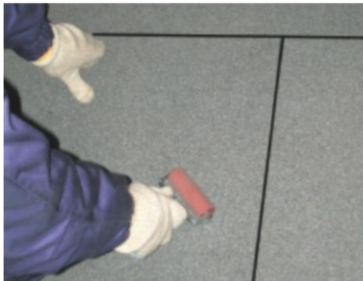
После удаления посыпки и подрезки уголка на место формирования торцевого нахлеста наносят слой мастики приклеивающей ТЕХНОНИКОЛЬ №22 (Вишера). Прикатать место склейки материала силиконовым роликом. Выдавившуюся мастику из-под бокового и торцевого шва присыпают сверху посыпкой. Нанесенную посыпку необходимо вдавить в мастику.
