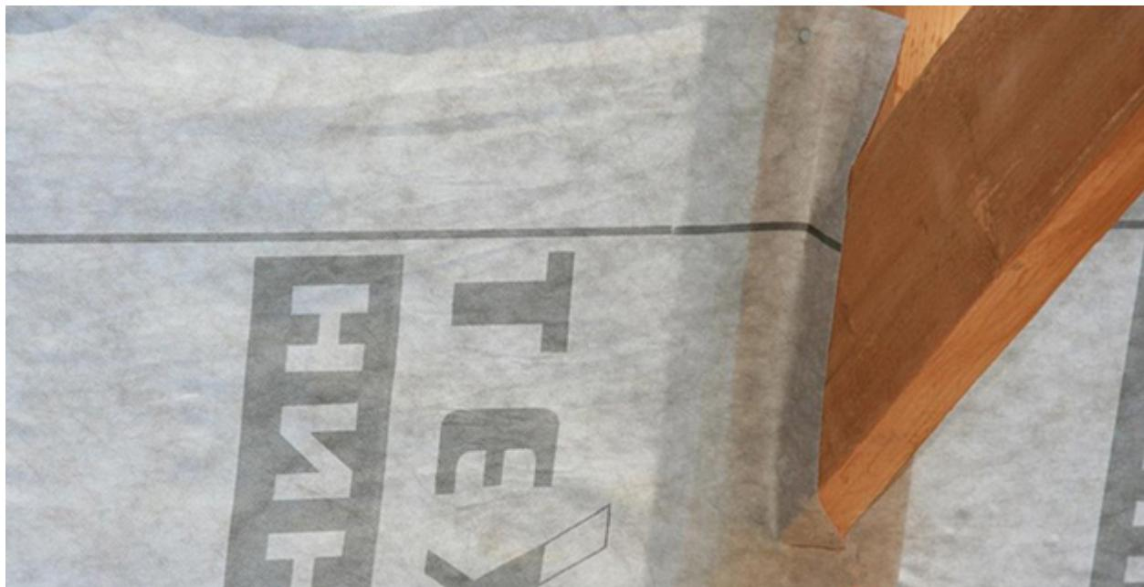
В местах нахлеста мембранны друг на друга пароизоляционную мембрану нужно надежно скреплять между собой двусторонним скотчем.
