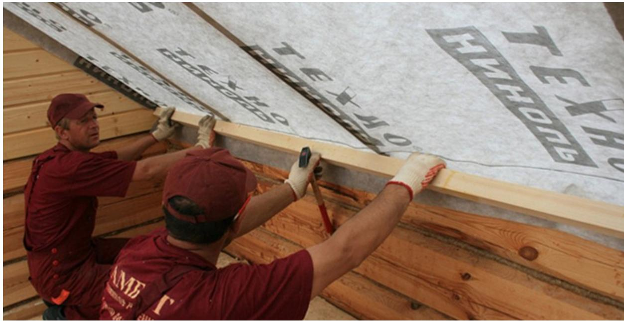
Мембрану от провисания закрепляют с помощью степлера или гвоздями. Для конструкций, которые выходят за границу покрытия нужно аккуратно вырезать мембрану вокруг них.
